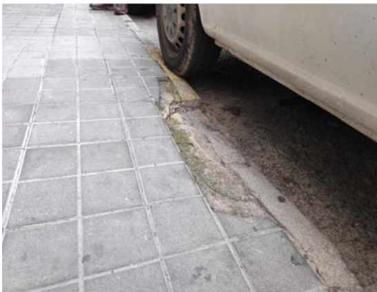
Foto 3: Baldosas partidas por altura de bordillo
