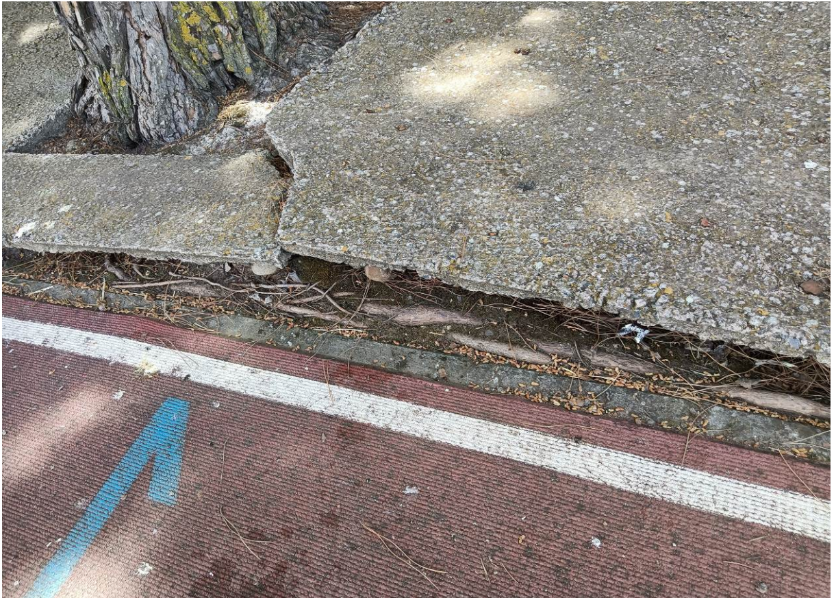
Estado actual del anillo perimetral de hormigón.
