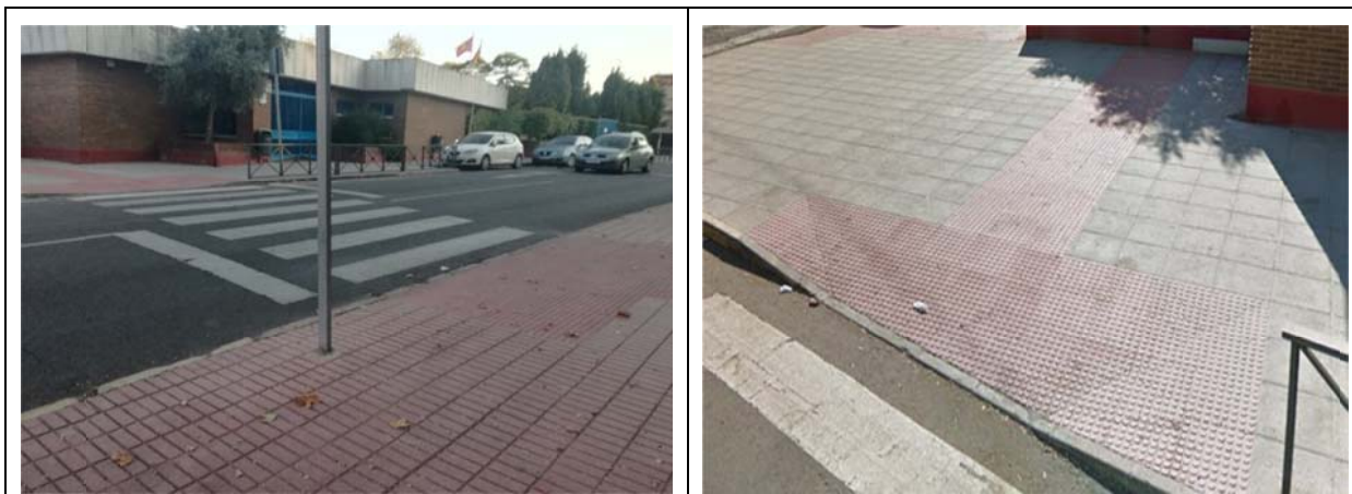
Paso peatones calle camino del Campillo
