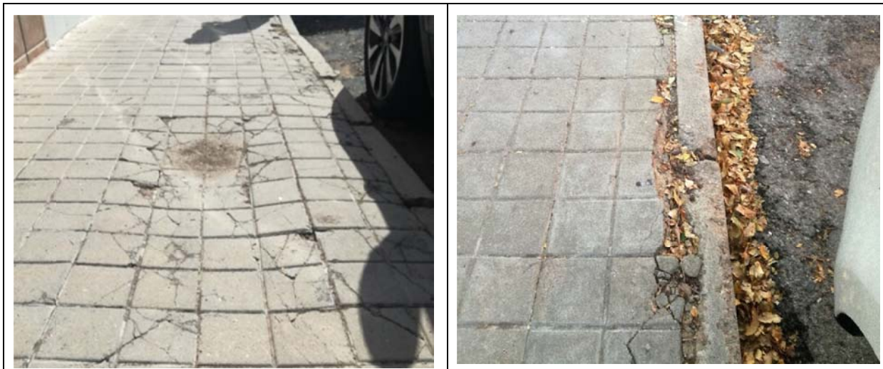
Estado del acerado: piezas deterioradas
