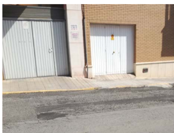
Vados de acceso a garajes: alteran la pendiente transversal de la acera
