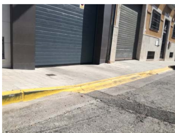
Vados de acceso a garajes: alteran la pendiente transversal de la acera
