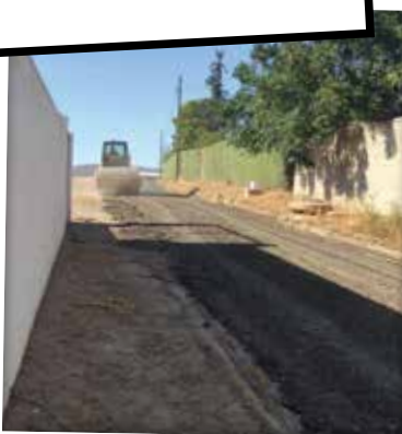
Arreglo del camino que va desde el cementerio a la depuradora
