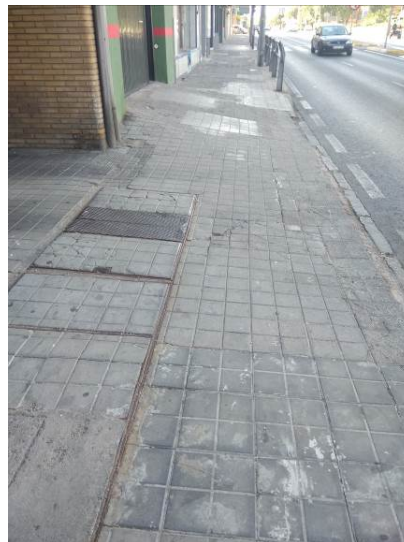
Foto nº2 .- Acerado y arquetas de baldosas.
