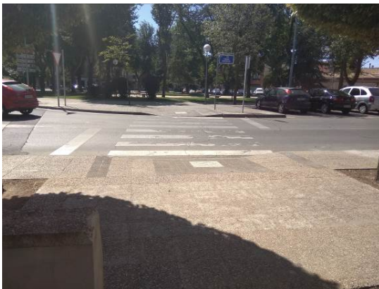
Foto nº 11 .- Paso de peatón a modificar.
