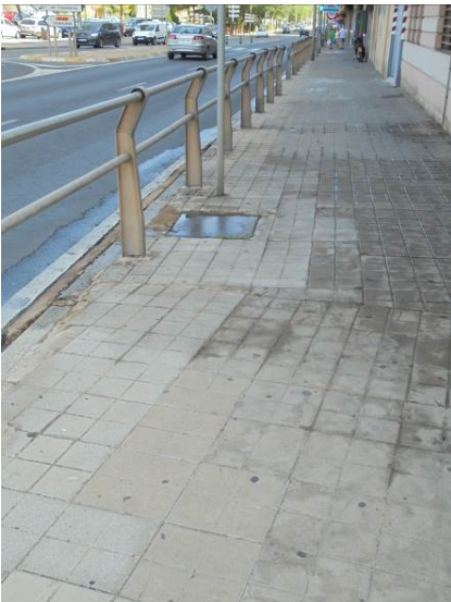
Foto nº4 .- Arquetas de metálicas
