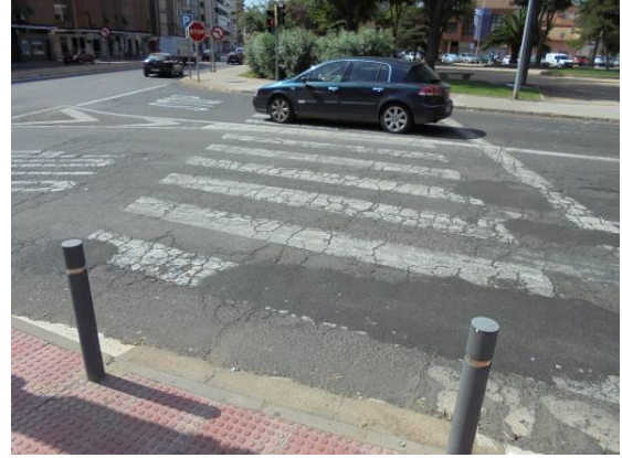
Foto nº 10 .- Modificación de Paso de P.
