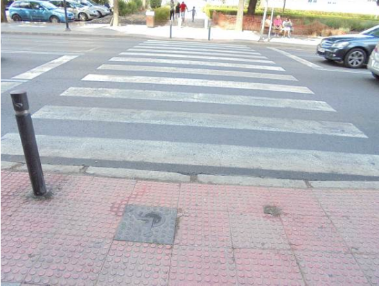
Foto nº .3- Reposición de bolardos.
