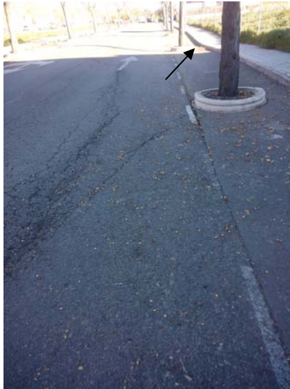
Foto 1: Zona de hundimiento 1
