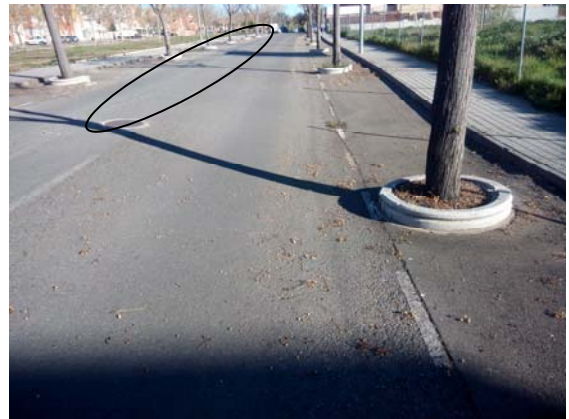
Foto 3: Zona de fisurada
