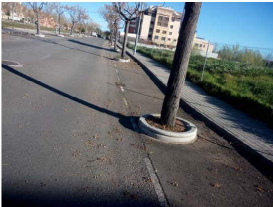
Foto 2: Zona de hundimiento 2
