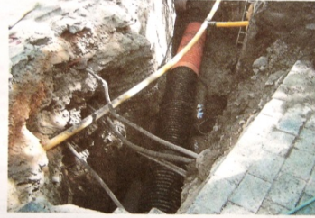
Tramo de colector instalado desde el pozo existente hasta la acometida del edificio.
