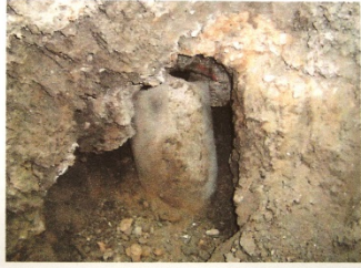
Se observa falta de continuidad en la acometida saneamiento de la Plaza de Cervantes núm. 5
