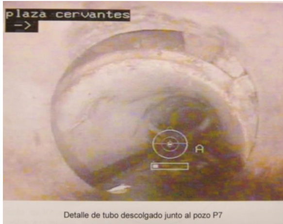
Foto 1º.- Detalle exterior de tubo del colector de hormigón zona "Z1" descolgado por asentamiento del terreno en Pza. de Cervantes.
