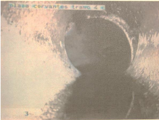
Foto 1º.- Detalle exterior de tubo del colector de hormigón zona "Z1" descolgado por asentamiento del terreno en Pza. de Cervantes.
