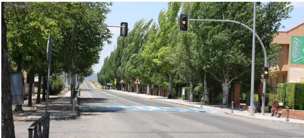
Figura 55: Carretera de Porzuna. Fuente: ESM.
