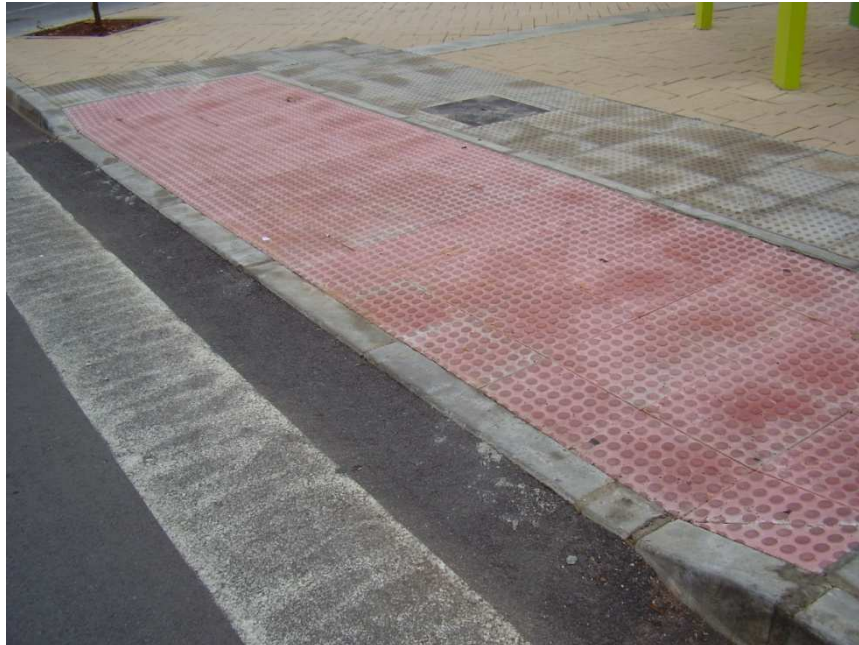
Figura 59: Viario interior de la estación de tren. Fuente: DOYMO.
