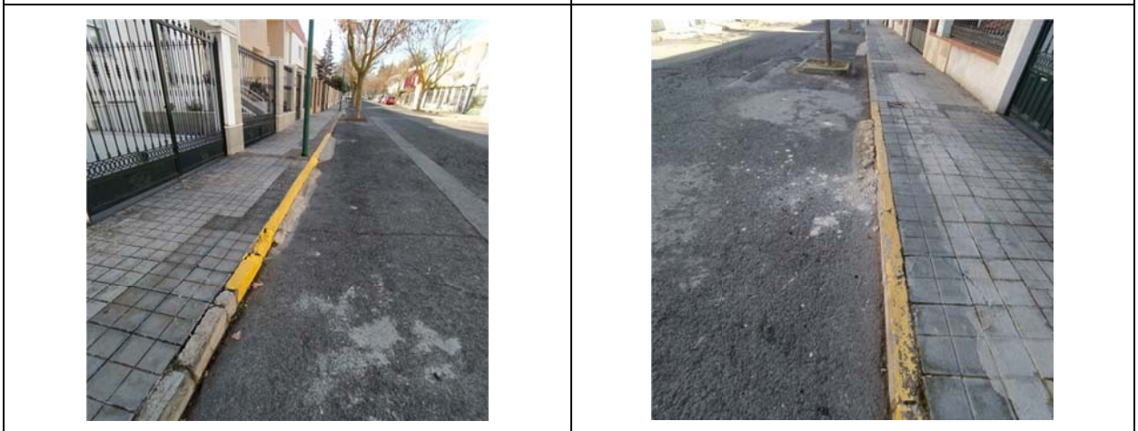
Rampas de hormigón junta al bordillo
